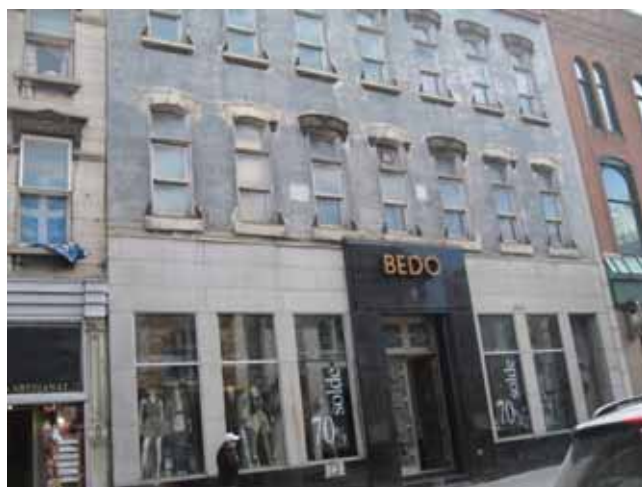
Une rénovation de qualité faciliterait l'occupation du bâtiment.
