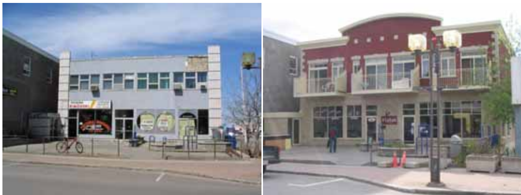
Le deuxième étage à nouveau occupé, ce bâtiment retrouve son caractère
